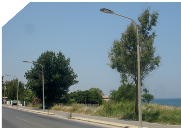
↙ Municipality of Kos. Street lights application. Δήμος Κω. Εφαρμογή σε δρόμο.
