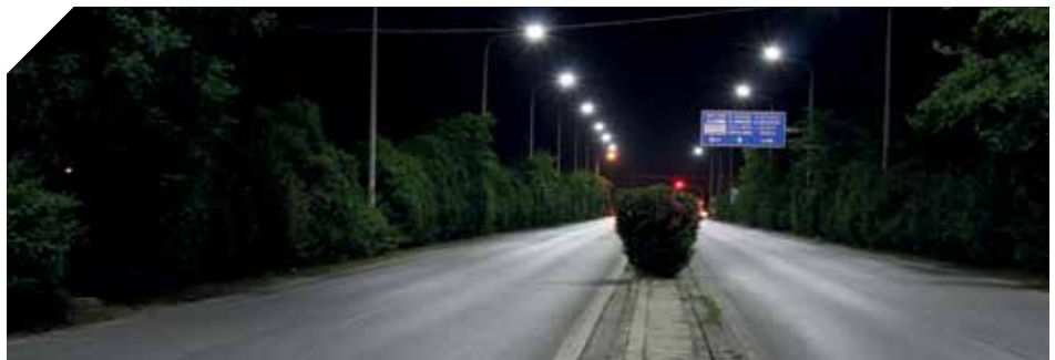
Part of street (A) with Dasteri LED Lighting Τμήμα δρόμου (Α) με Dasteri φωτιστικά Τύπου LED
