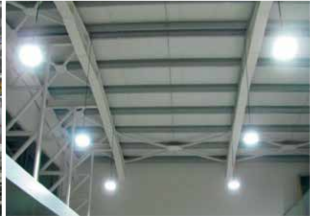
Storage room lights application. Εφαρμογή σε αποθηκευτικό χώρο.
